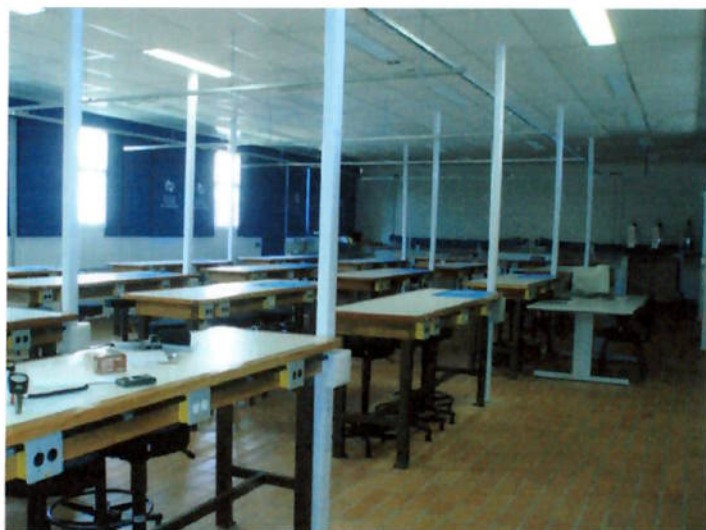
Foto 7 – Vista das bancadas com detalhe das descidas de elétrica dos laboratórios de Física.
