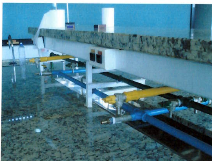
Foto 5 – Detalhe das tubulações de utilidades das bancadas dos laboratórios de Química
